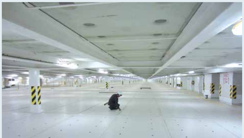
Fertiggestelltes Komposit-Deck in einem RoRo-Schiff von Uljanik
