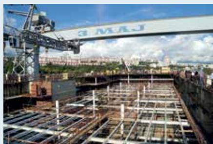
Stahlstruktur für Kompositpaneele auf einem RoRo-Deck, 3. Maj Shipyard, Rijeka Foto: CMT
